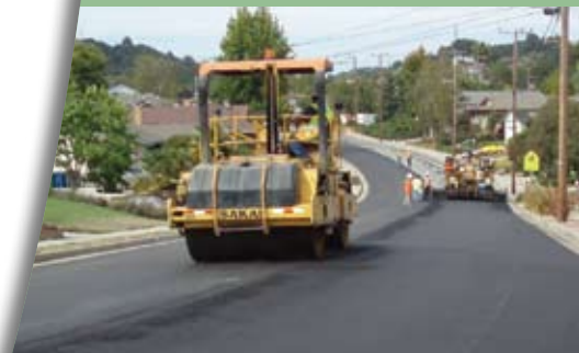
Revestimiento de pavimento en Cabrillo Avenue
