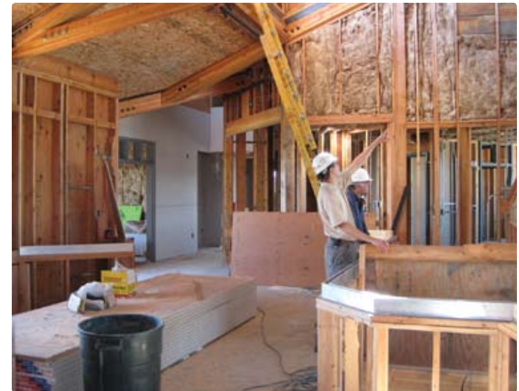
Interior del Centro de Recursos de Live Oak durante la construcción
