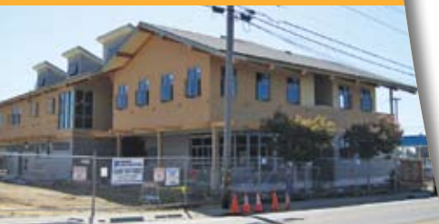
Centro de Recursos de Live Oak en construcción
